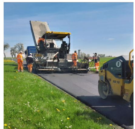
Einbau der Asphaltdeckschicht auf der K 7332 bei Grötzingen
