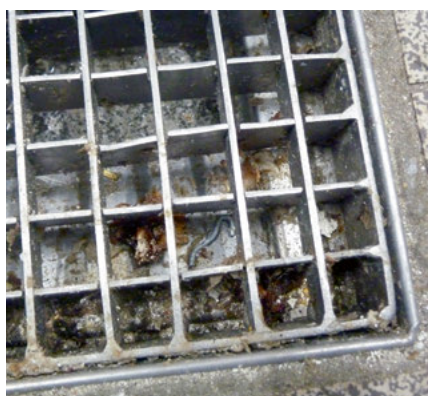
Stark verunreinigter Bodenablauf in einem Lebensmittelbetrieb
