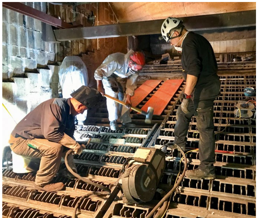
Der Verbrennungsrost Kessel ist ständig Temperaturen von über 1200 Grad Celsius ausgesetzt und muss daher regelmäßig gewartet werden
