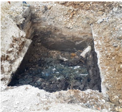
Bodenverunreinigungen an einem schadhaften Ölabscheider
