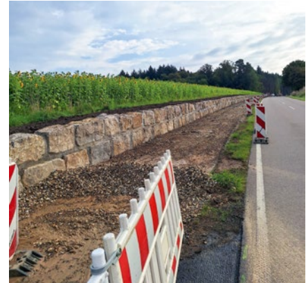
Die neue Naturstein-Stützmauer entlang des Rad- und Fußweges von Beuren nach Illerrieden
