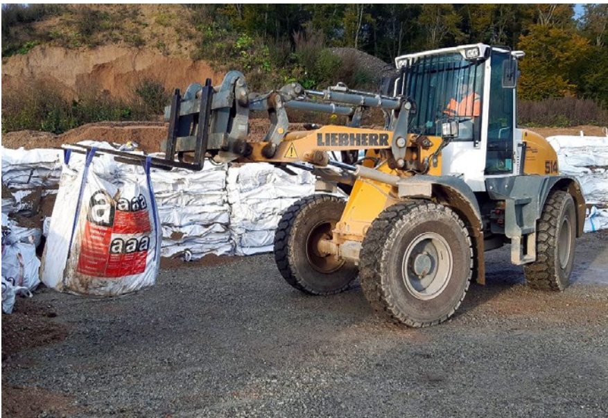
Einbau von Asbest in speziellen Big Bags auf der Deponie „Unter Kaltenbuch“
