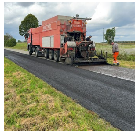
DSK (Dünne Schichten in Kaltbauweise) Einbau zwischen Frankenhofen und Grötzingen
