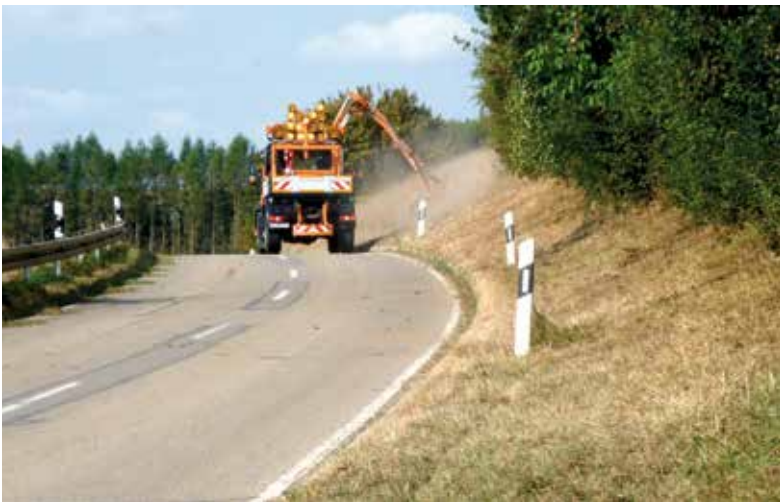
Straßenböschungunterhaltung im heißen Sommer 2018
