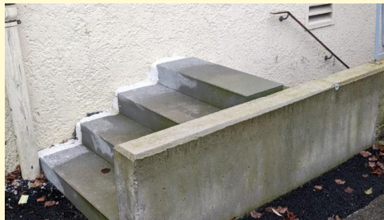
[Erhöhung Lichtschacht (links), Erhöhung der Außentreppen zum Keller (rechts), Fotos: Fiona Pregizer]
