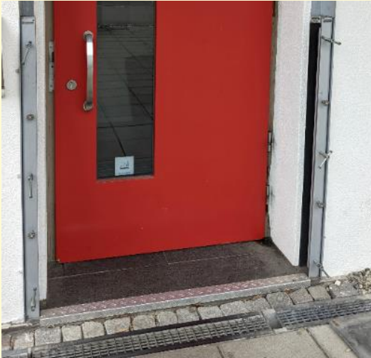
[Türschott (links), Rückstausicherung für Abflüsse unterhalb der Rückstauenebene = Straßenoberkante (rechts), Fotos: Fiona Pregizer]
