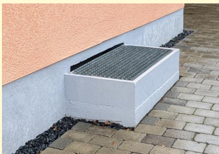
[Erhöhung Lichtschacht (links), Erhöhung der Außentreppen zum Keller (rechts), Fotos: Fiona Pregizer]
