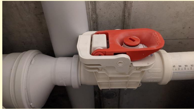
[Türschott (links), Rückstausicherung für Abflüsse unterhalb der Rückstauenebene = Straßenoberkante (rechts), Fotos: Fiona Pregizer]
