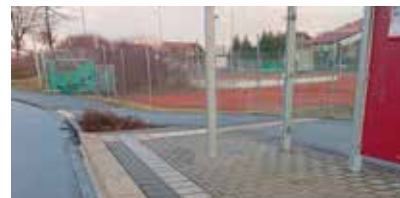
Barrierefreie Bordsteine an den Bushaltestellen (sog. Kasseler Borde) sind ab dem Jahr 2022 Pflicht.
