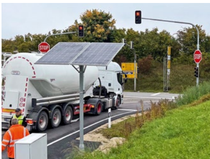
Ampel mit PV-Modul
