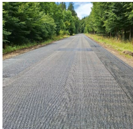
Verlegung Asphaltbewehrung (Glasfasergitter)
