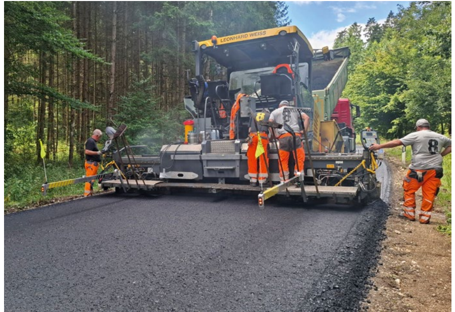
Einbau Niedrigtemperaturasphalt
