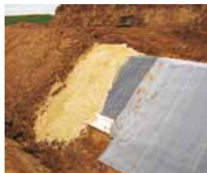
Abdichtung der Böschung.
