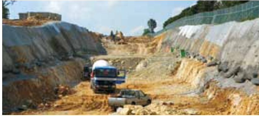
Vorbereitungen zu einer Sprengung.
