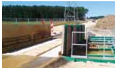
Reifenwaschanlage auf der Baustelle.
