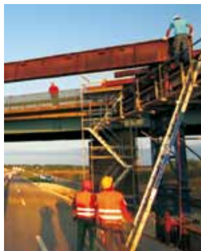
Arbeitsschutz- überprüfung vor Ort.
