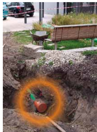
Nahwärmenetz-Leitung.
