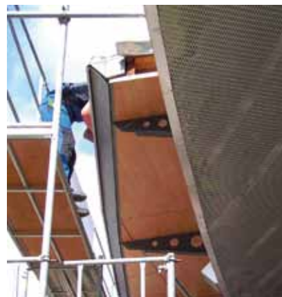
Dachsanierung bei der Gewerblichen Schule.
