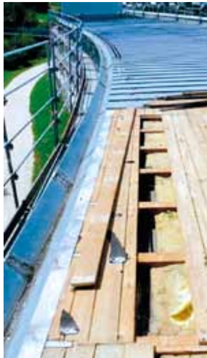
Dachsanierung beim Theoriegebäude der Gewerblichen Schule in Ehingen.
