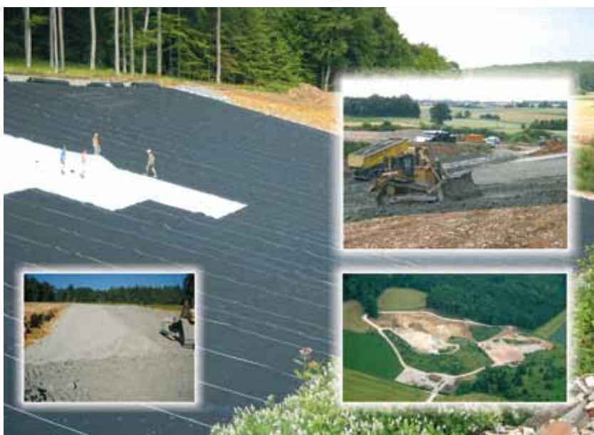
Erweiterungsarbeiten auf der Bauschuttdeponie Unter Kaltenbuch, Laichingen-Suppingen (großes Bild: Aufbringen der Kunststoffdichtungsbahn)
