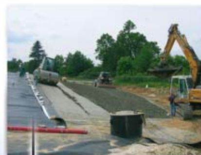
Sanierungsarbeiten auf der Deponie Ulm-Eggingen.
