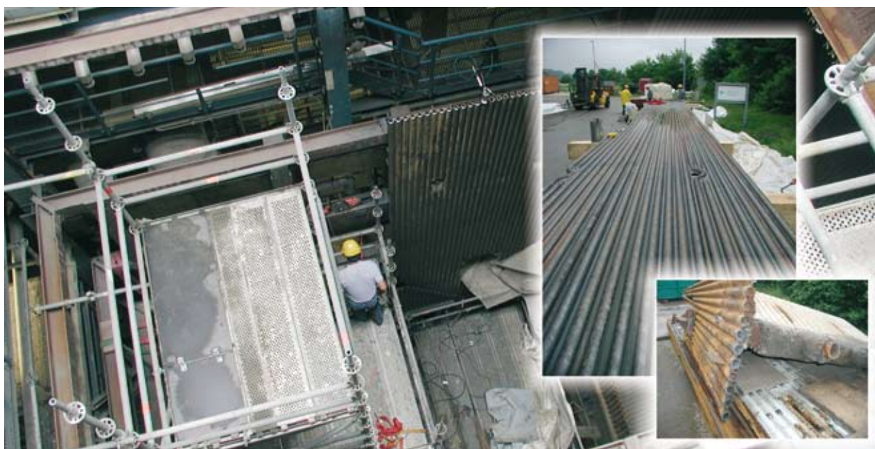
Arbeiten am Müllkessel (Verbrennungslinie) im Müllheizkraftwerk.
