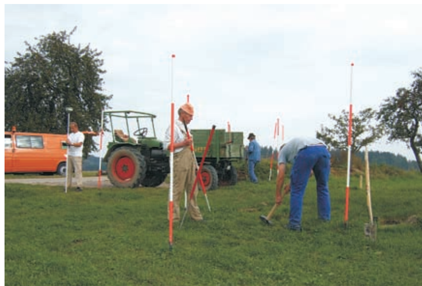
Absteckung mit GPS-Technologie (links) und Abmarkung (rechts) der neuen Grenzen
