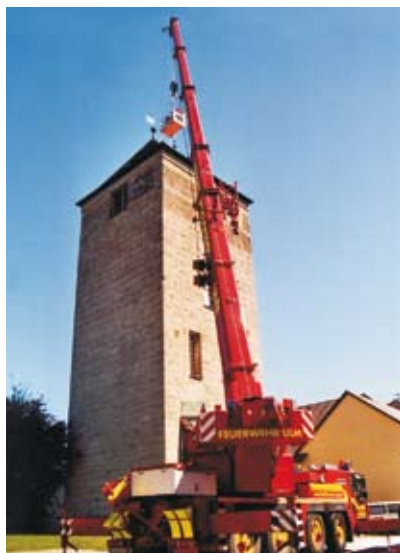
Installation der neuen Antennenanlage auf dem Römerturm in Emerkingen mit dem Feuerwehrkran der Feuerwehr Ulm
