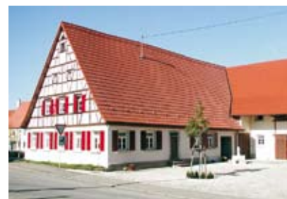
Mit ELR-Mitteln erneuert: Hofanlage in Amstetten-Stubersheim vor und nach der Sanierung
