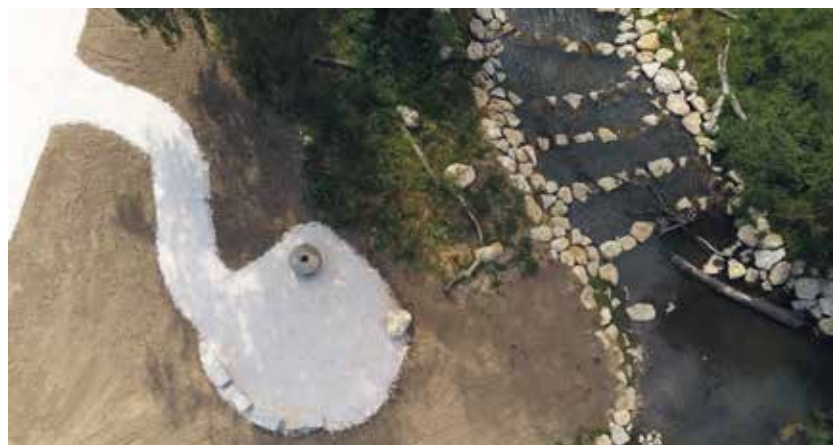
Nachher: Luftbild der neuen rauen Rampe am ehemaligen Ausleitungswehr mit Erlebnisbereich.
