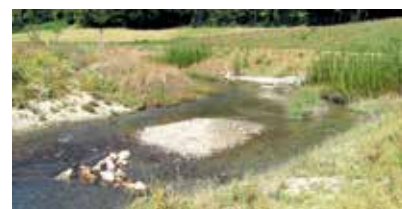
Nachher: Gewässerabschnitt der renaturierten Weihung mit Kiesbänken und Störsteinen zur Schaffung von strömungsberuhigten und dynamischeren Bereichen.
