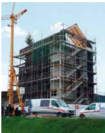
Richtfest bei Wohn- und Geschäftshaus in Amstetten-Schalkstetten – ELR-gefördert.
