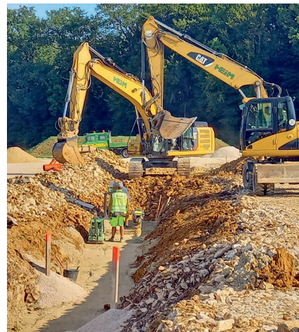
Entsorgungszentrum Laichingen im August 2022
