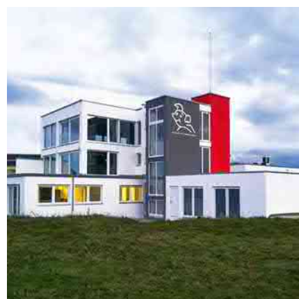
ELR-gefördert: Neubau für einen Metzgereibetrieb in Öpfingen.
