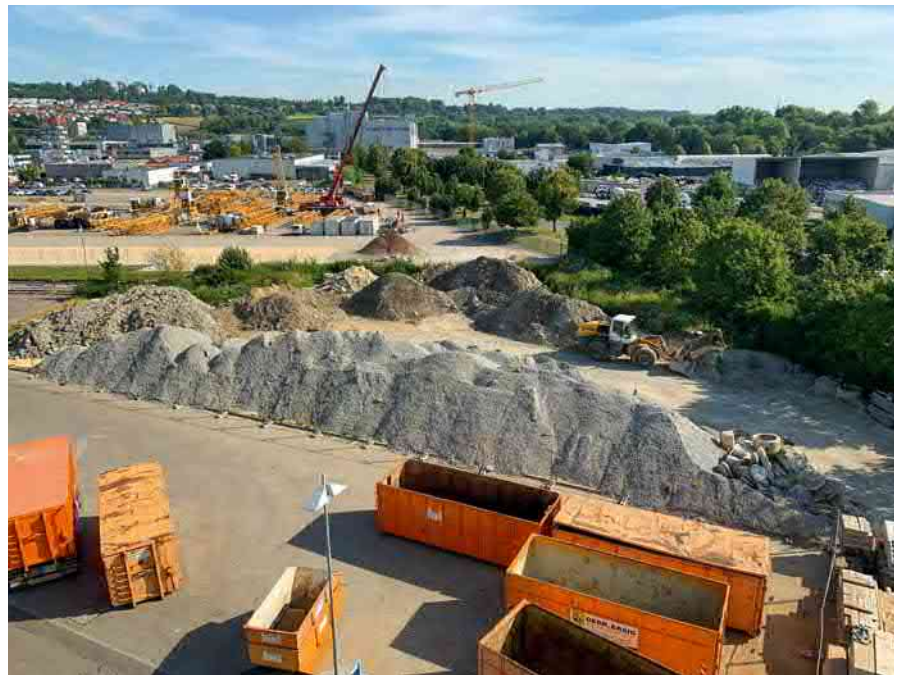
Abbruchmaterial wird zu Recyclat-Baustoffen
