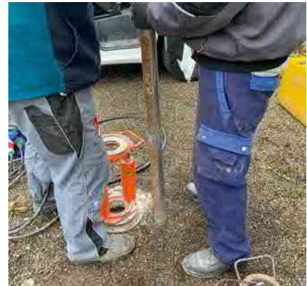
Sondierung auf einem ehemaligen Gewerbestandort.
