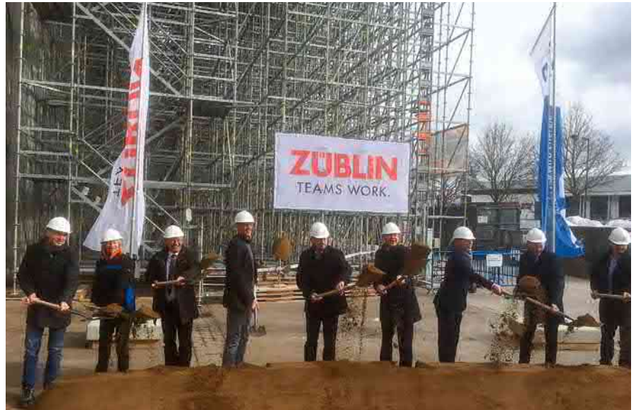
Spatenstich beim Müllbunker und der Entladehalle.
