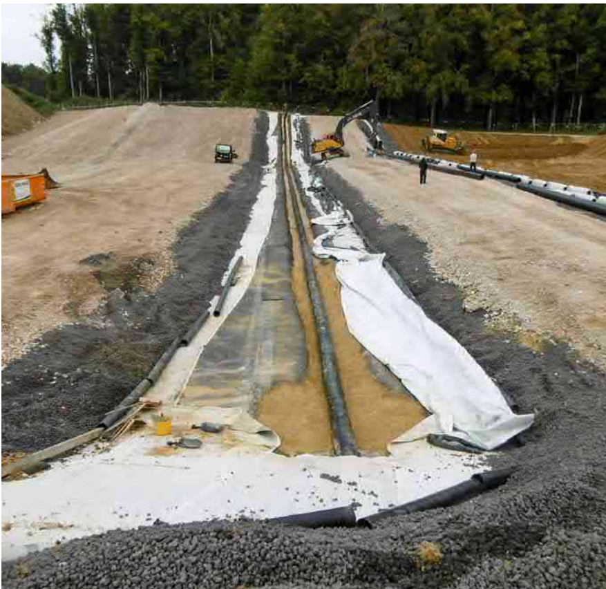
Deponie Unter Kaltenbuch – Deponieabdichtung mit Sickerwasserleitung
