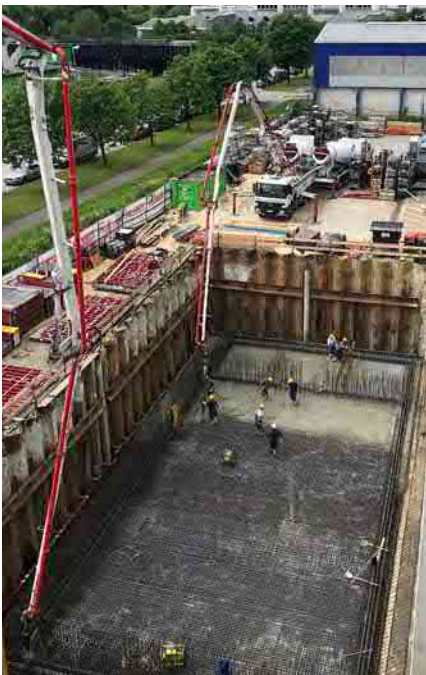
Bunkererweiterung: Bodenplatte wird eingebaut.
