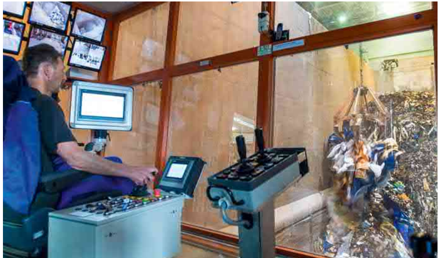
Krankanzel im Müllbunker des Müllheizkraftwerks Ulm-Donautal – hier landet auch der Hausmüll aus dem Alb-Donau-Kreis.
