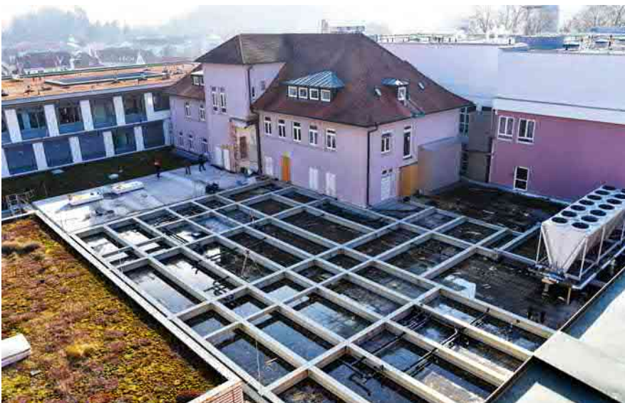
Stahlträgerkonstruktion auf dem Dach des Klinikgebäudes in Blaubeuren für die neue Intensivstation.
