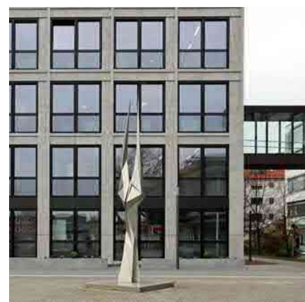
Das neue „Gebäude B“ der Kreisverwaltung – vom Rohbau bis zur Fertigstellung.
