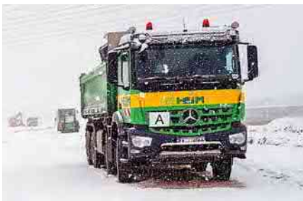
Straßenbau im Winter – kein Vergnügen, aber machbar.
