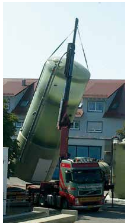
Die neue Soleerzeugeranlage wird bei der Straßenmeisterei Ehingen aufgebaut.
