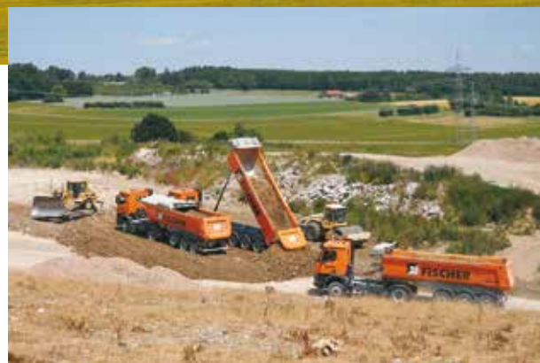
Erdaushub und Bauschutt auf dem Weg zur Deponie „Unter Kaltenbuch“ in Laichingen-Suppingen.
