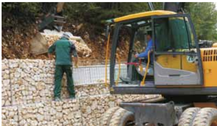
Befüllen der Gabionenwand
