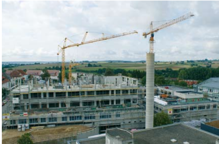
Bauarbeiten beim Gesundheitszentrum Ehingen
